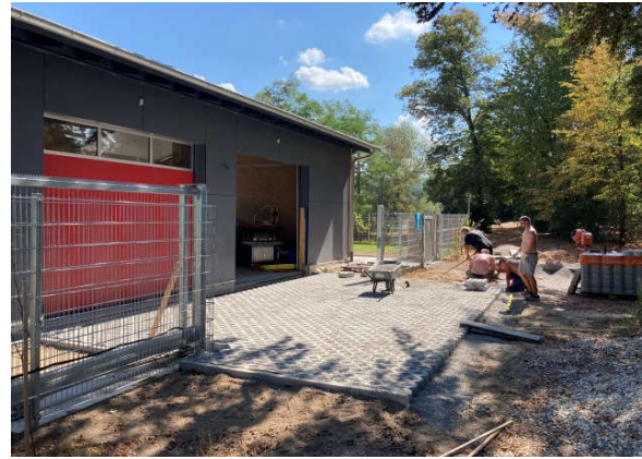
Arbeitseinsatz beim Bau der Einfahrt
