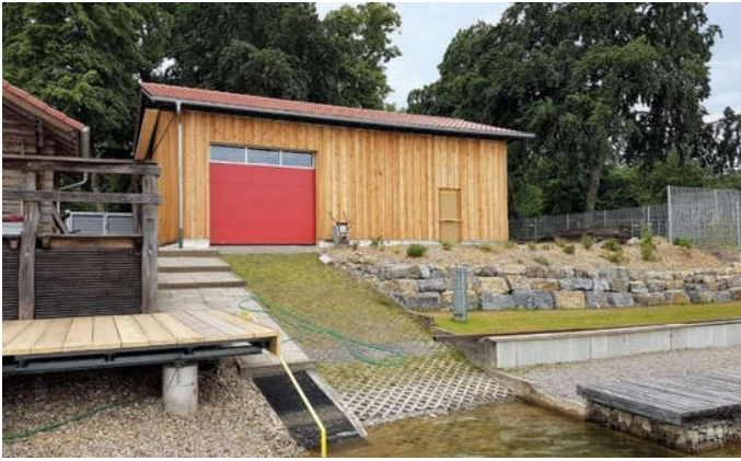
Ansicht des Bootshauses von der Seeseite
