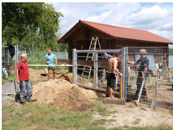
Arbeitseinsatz an der Zaunanlage
