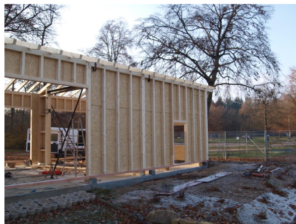
Bootshaus im Rohbau (Dezember 2019)
